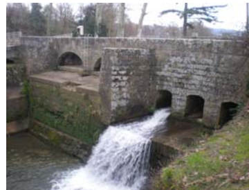
- L'épanchoir des Thoumasés - Cliché : RISQUE & TERRITOIRE.
